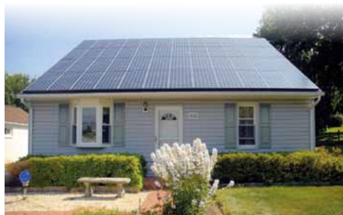
Рис. 5. Солнечная батарея на крыше здания
