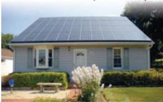
Мал. 5. Сонячна батарея на даху будівлі
