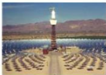
Мал. 9. Сонячна електростанція з геліоконцентратором
