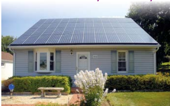
Мал. 5. Сонячна батарея на даху будівлі
