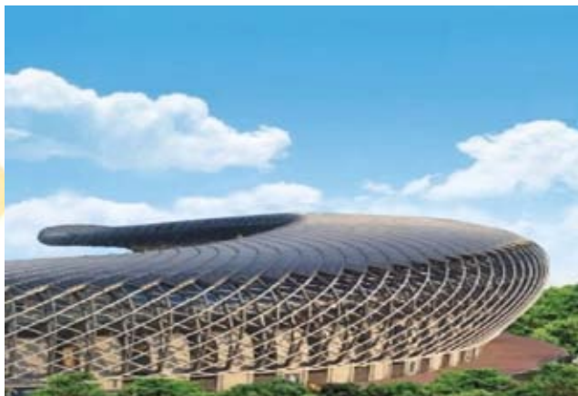
Мал. 10. Сонячна електростанція з піднятими фотоелектричними модулями
